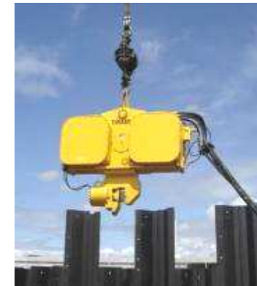
Vibrationsrammen für den Tiefbau
